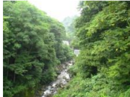
写真3：山奥に見える砂防堰堤
