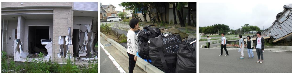
富岡町の風景(地震と津波で壊れたアパート、汚染物の前に立つ、壊れた建物)
